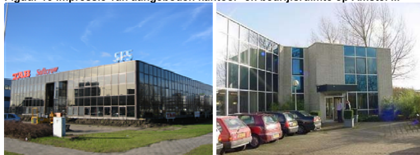
Figuur 13 Impressie van aangeboden kantoor- en bedrijfsruimte op Amstel III
